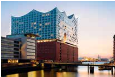
HAMBURGO THE WESTIN HAMBURG ELBPILHARMONIE Upper Upscale 244 habitaciones, 39 de ellas suite Un restaurante, un bar Zona de spa de 1.300 m² con piscina 826 m² de zona de conferencias
